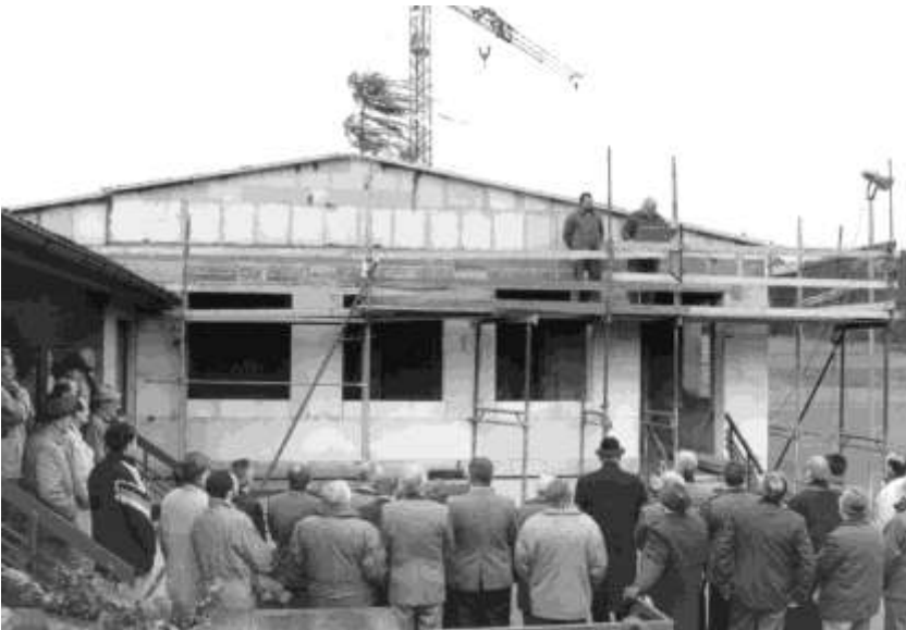
Richtfest für das neue Schützenhaus
